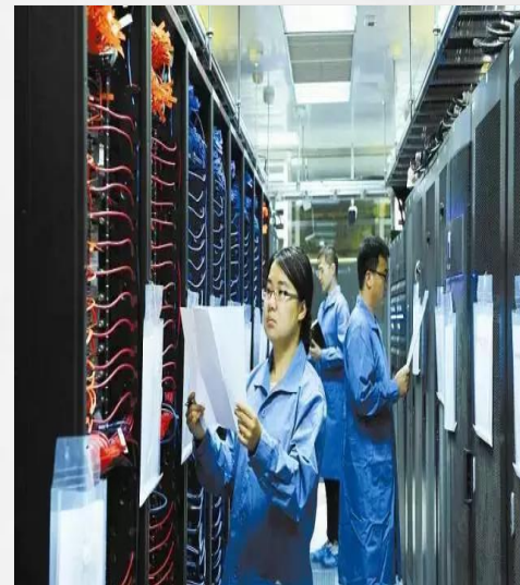
巡检数据管理不便
